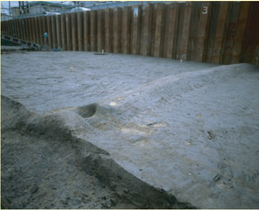
▼ あぜの水口(みなくち) 田んぼから田んぼへの水の通り道です
