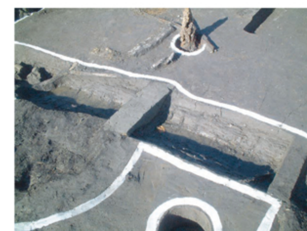
写真3 排水溝内の木質構造物
