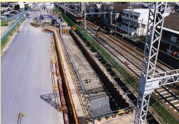
99-3区中世集落跡（西北西から） 建物の柱穴や井戸、溝などが数多く検出でき、長い期間にわたって村が続き、人びとが住んでいたと分かります。
