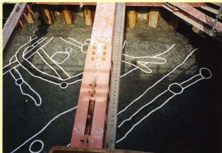
99-4区建物・溝跡（南から） ムラのまわりは低い土地であったようで、住みやすくするために、住居やその周辺に溝を掘り排水を行っています。
