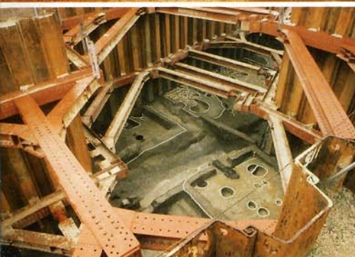
外周部（二重矢板内）の調査
