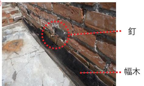
建物内の間仕切りと壁が接するところには、一部で壁に間仕切りの幅を示す墨打ちが確認できます（⑬の▲）。壁と床が接するところには、花岗岩が多く用いられます（⑬）。しかし、南翼の一部では、その代わりに板材を使用した箇所があります（⑮）。壁に墨打ちが残るところもあり（⑭の▲）、板材の高さは43 cm程のようです。この幅木が一部で残存しており、壁には煉瓦の代わりに、木材が埋め込まれて、打ち込まれた釘も残っていました（⑮）。
