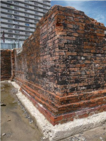
建物の基礎は、コンクリートで、その上に煉瓦をオランダ積で積み上げます（⑩）。オランダ積とは、各段横方向に狭い面（小口）と細長い面（長手）を交互に積む方法のうち、コーナー部に「七五（しちご）」という、通常の大きさの煉瓦を短辺方向で4分の3（75%）にした大きさの煉瓦を使うものをいいます。煉瓦は、水平に積まれていない部分があります。北翼タイル敷きの区画では、特に明瞭です（⑪）。明治時代以来の庁舎があるところでは、その方向にもたれかけるようにしています（⑩の左の△）。このように意図的ではなく、水平ではない積み方をするところがあります（⑩の右の△）。積み方を間違えたのでしょうか。また、積み方や使っている煉瓦が、明らかに変化しているところ（⑫の▲）もあり、煉瓦積み職人の施工単位を示しているのかもしれませんが。ちなみに、この区画に敷かれているタイル（⑪）の製造会社は不明なのですが、タイルの特徴からは、大正時代増築時に敷かれたと考えてよさそうです。
