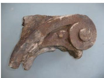
大正の増築の際に使用されたものと考えられます。材質はモルタル(いわゆる「擬石」)です。明治当初の柱頭飾りなどの建築材料は、現状で未確認です。当初のものであれば、石で作っていたかもしれません。
