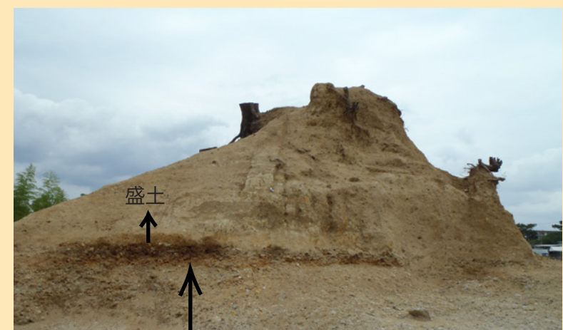
土塁（南から）。茶色の層は段丘の礫層。これより上の層はすべて盛土です。
