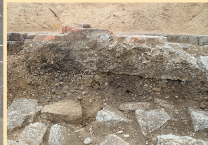
⑥コンクリート床上にはれんがが積みによる壁がわずかに残ります。基礎には間知石を横に並べています。
