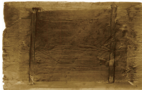
写真13 蟻溝加工の机天板（裏面）
