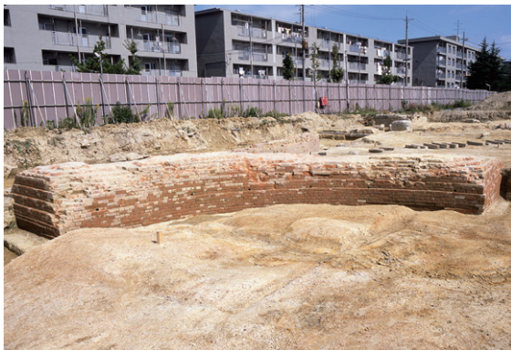
写真8 2号乾燥火薬庫煉瓦構造物裏側
