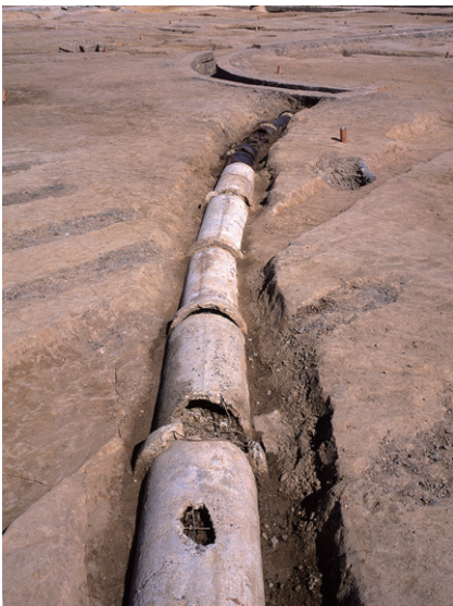
写真 12 土管とヒューム管
