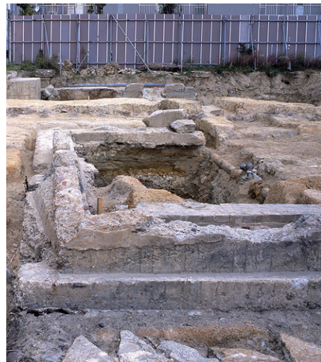
写真9 第30号倉庫西壁の基礎
