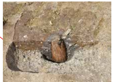
柱の根元部分が腐らずに残っていました。
