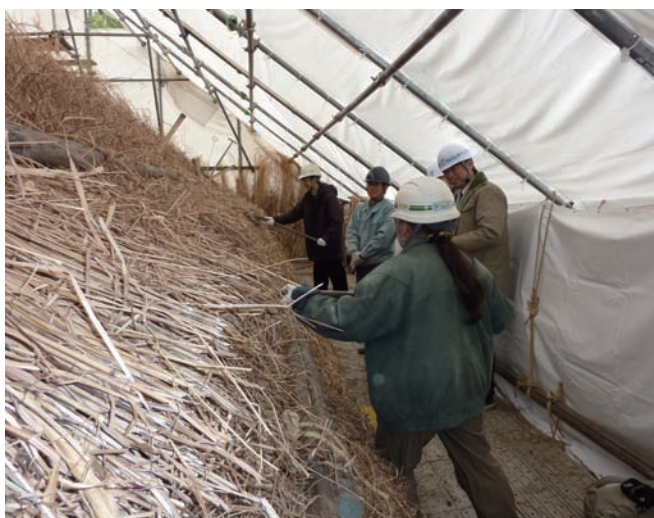
民家の修理（摂津能勢の民家）
