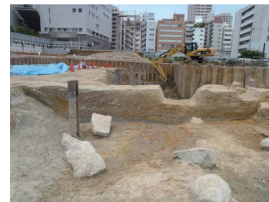
▲46 堀 堀の底に捨てられた残石群。
