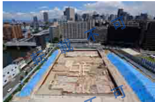
調査地全景(南から)
